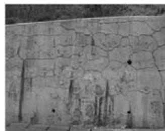
写真1 ASRによる損傷事例
