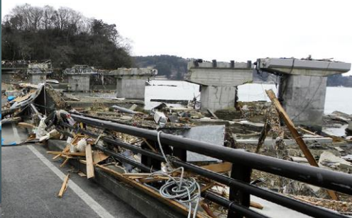
歌津大橋(震災後)
